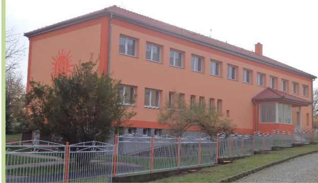
Budova mateřské školy po rekonstrukci a úpravách okolí.
